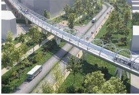
Le strutture hanno tutte la medesima concezione; si tratta di un ponte ferroviario-metropolitano a doppio binario a via inferiore. Le pile sono metalliche ed incastrate alla struttura dell’impalcato, rendendo di fatto la struttura a telai consecutivi, con campate di luce variabile intorno ai 30m.
