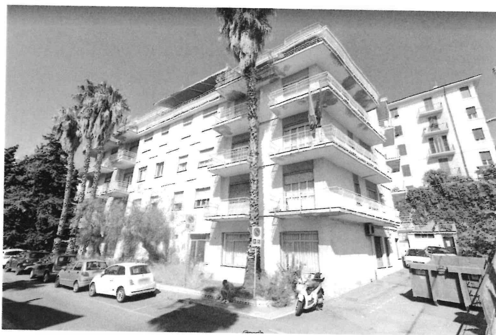
Vista sud-est da Viale Giacomo Matteotti
