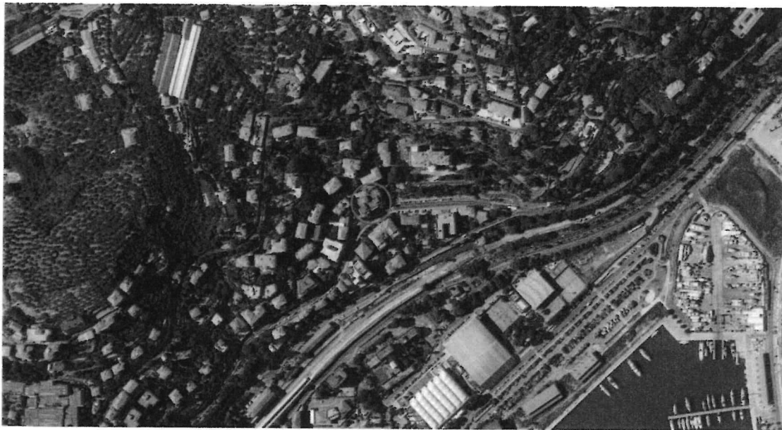
Vista generale con indicazione della collocazione dell'immobile
