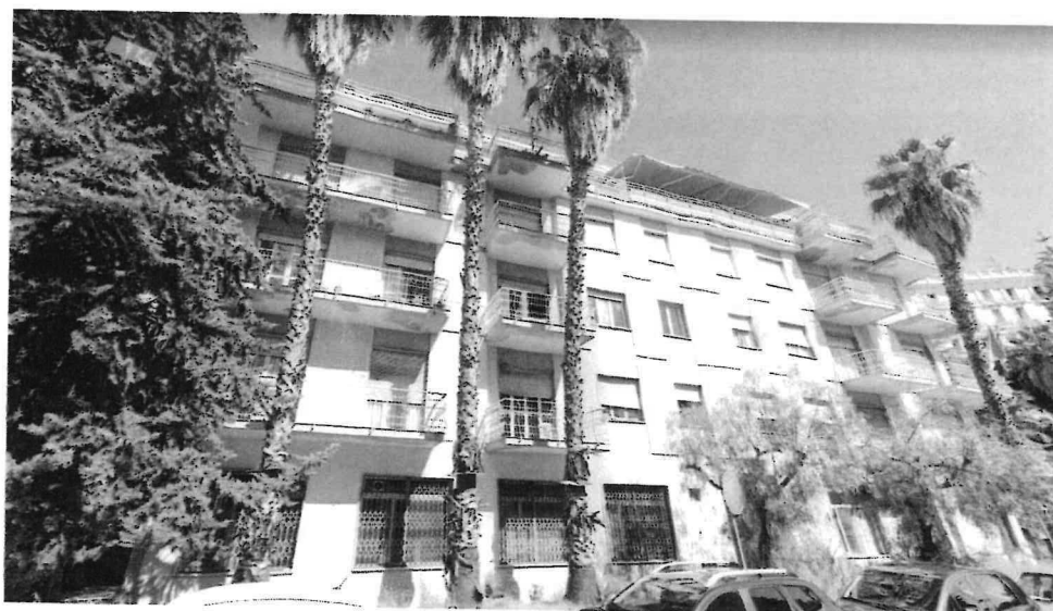
Prospetto sud visto da Viale Giacomo Matteotti
