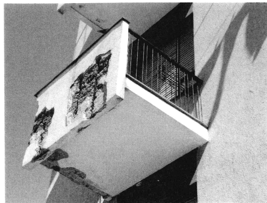
1: (in alto) prospetto sud e (in basso) porzione prospetto sud con segni di degrado.
