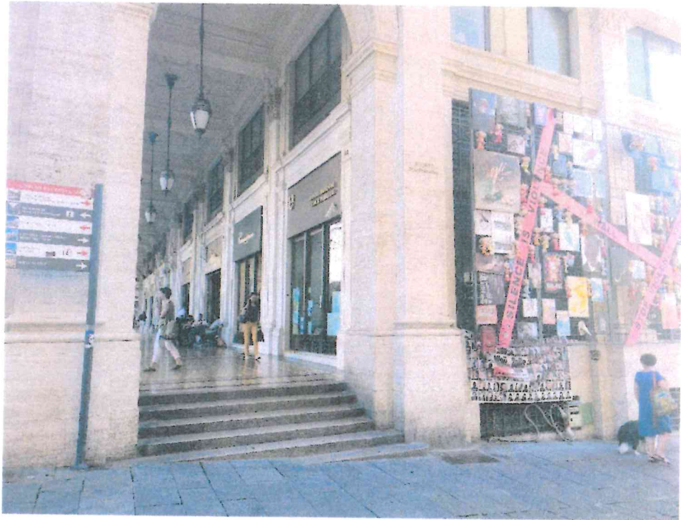
Vista dell'ingresso dal porticato prospettante Piazza De Ferrari
