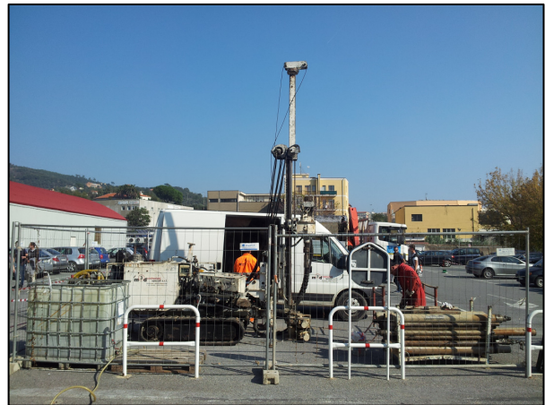
Foto 1 – Postazione Sondaggio S1
