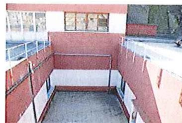
Il **piano III**, frutto di un'opera di sopraelevazione attuata successivamente alla costruzione dell'edificio, è ridotto nell'ingombro rispetto al perimetro ed è caratterizzato, analogamente agli altri piani in disuso, dall'abbandono e pertanto versa in un pessimo stato di manutenzione; a questo piano i serramenti non sono stati sostituiti.
