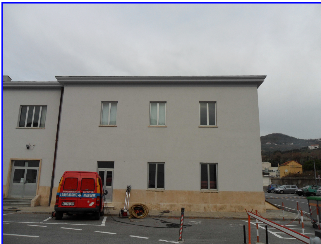
Vista esterna della zona di collaudo.
