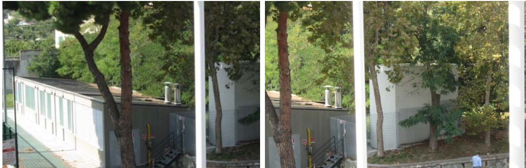
Figura 2.1: Centrale Termica e Vano Microturbina Esistenti
