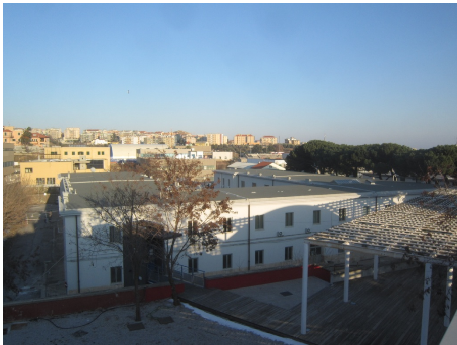
Figura 3.2: Copertura Palazzina Delfino per Impianto Fotovoltaico
