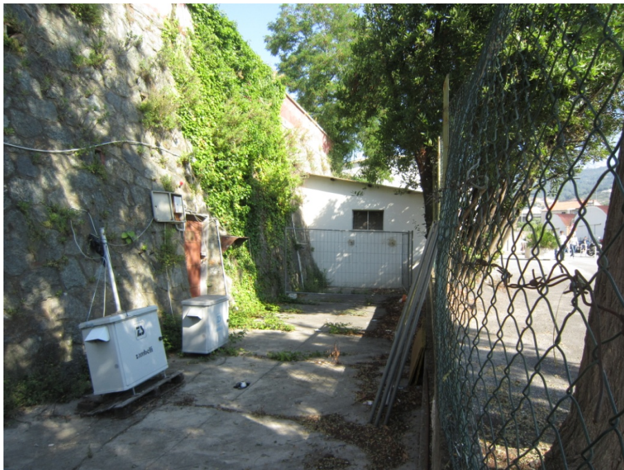
Figura 3.5: Area per Installazione Accumulo Elettrico
